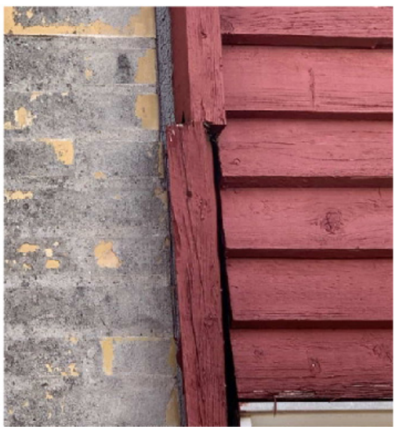
Planke ved klinkbeklædning med råangreb
