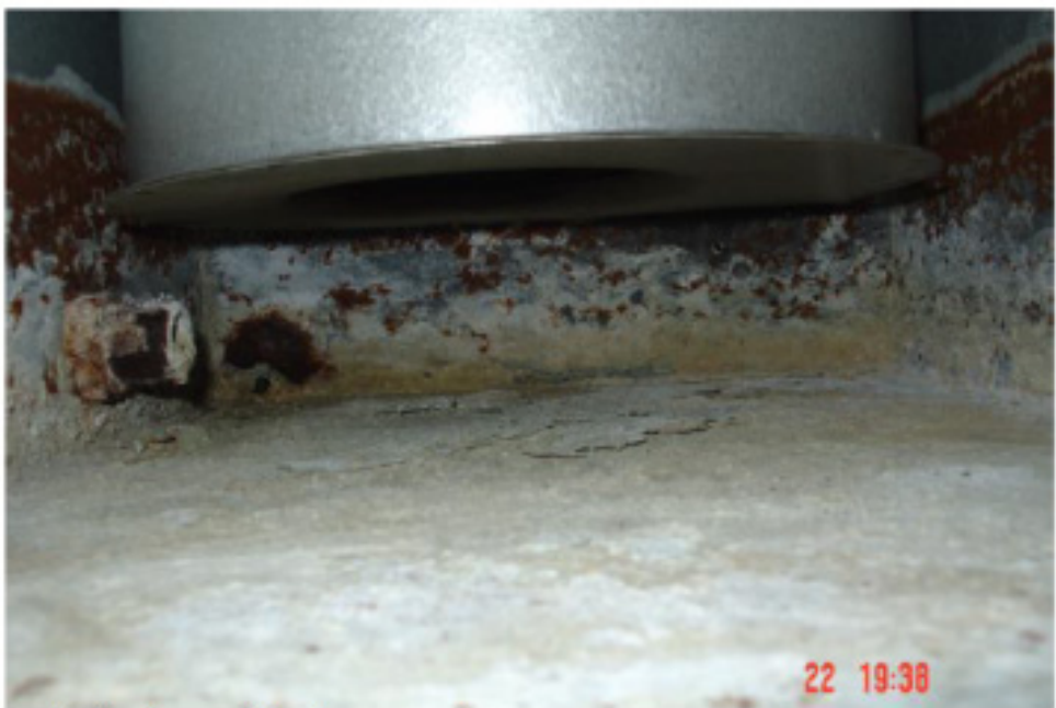
Der er rustangreb på mange dele i ventilationsanlæggene.
