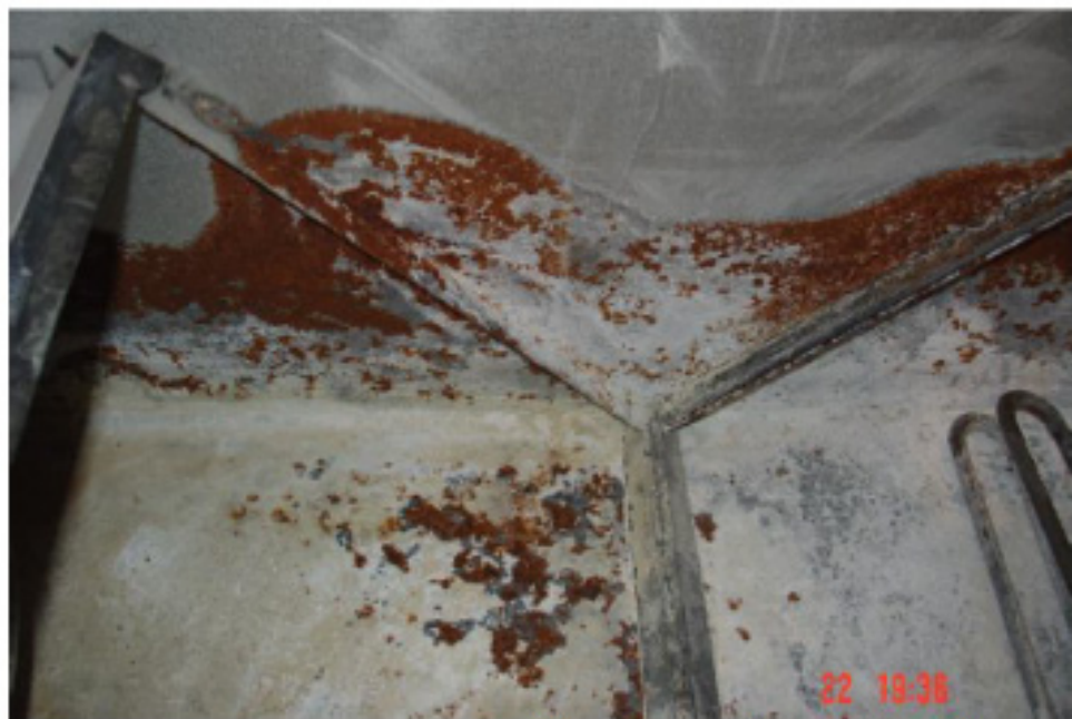
Der er rustangreb på mange dele i ventilationsanlæggene.
