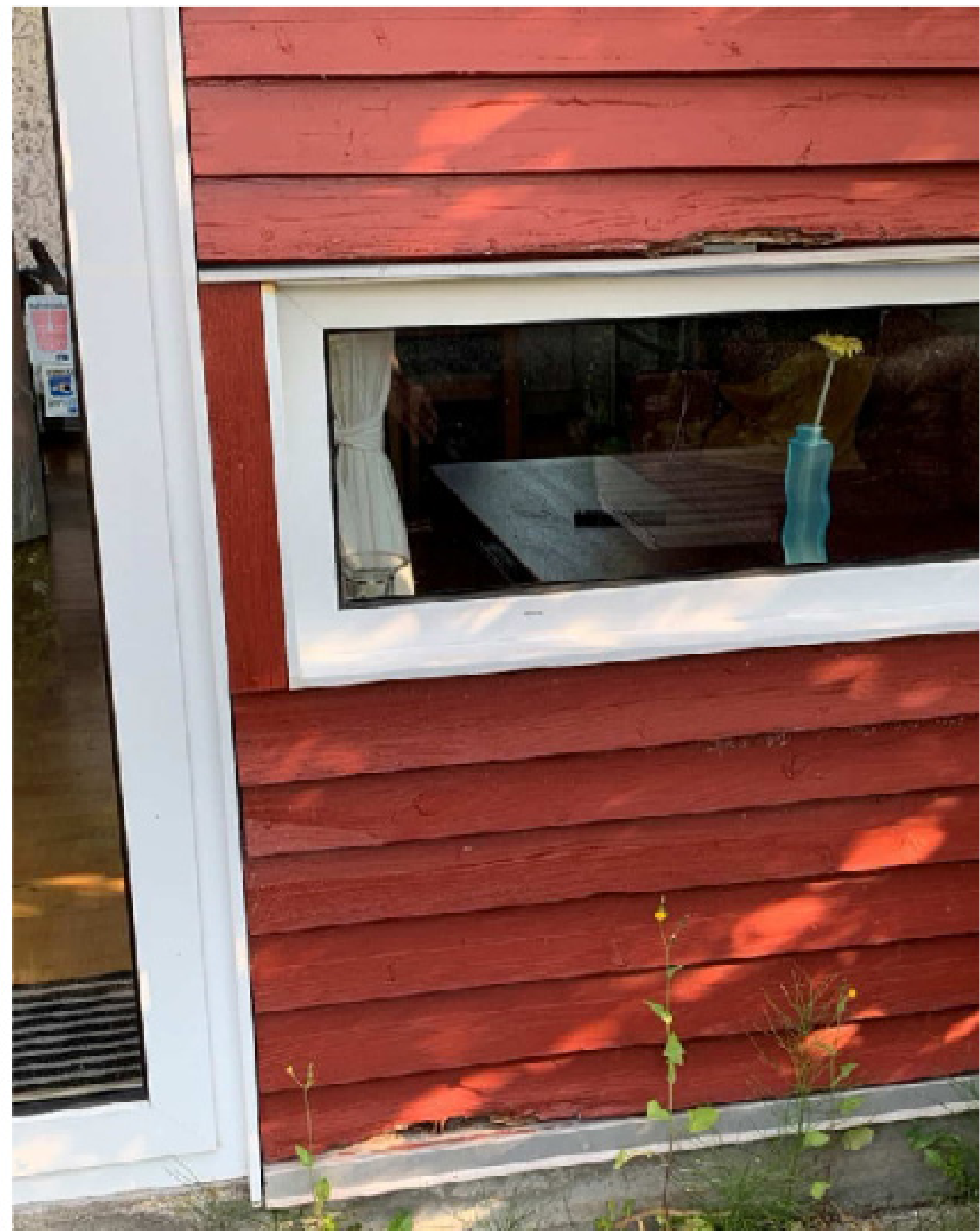
Planke ved klinkbeklædning med råangreb
