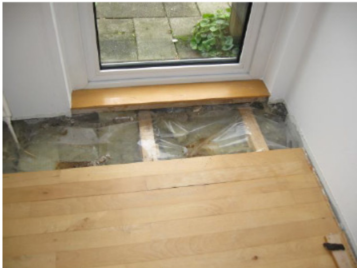
Gulvbrædder er fjernet.
